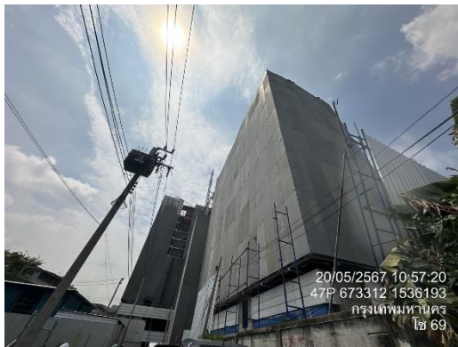
รูปที่ 69 ผ้าใบ Mesh sheet
