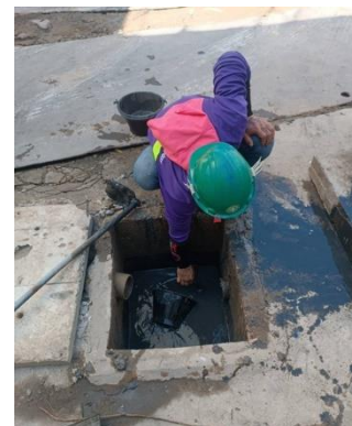
รูปที่ 78 คนงานทำความสะอาดบ่อดักตะกอน
